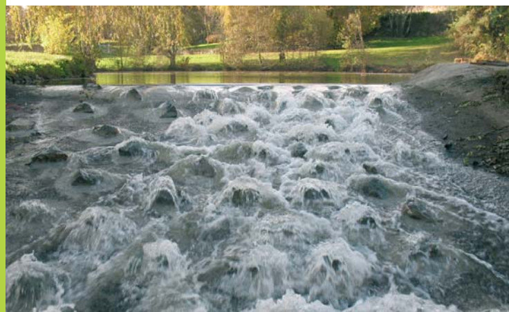
Aménagement d'une passe à anguilles, commune du Tallud. © Olivier CONSTANTIN.
